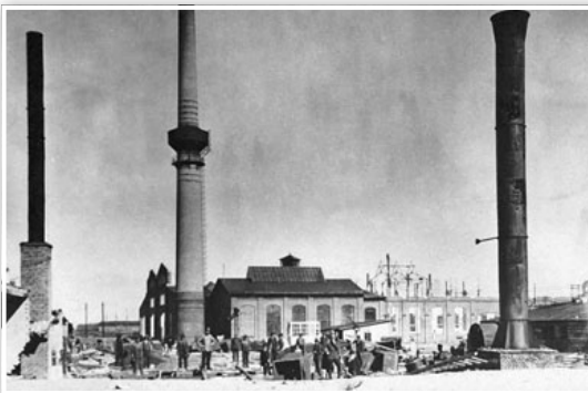
1913. gads. Rūpnīcas centrālās katlu mājas celtniecība.
