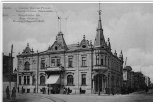
Krievijas - Austrumāzijas tvaikoņu sabiedrības administratīvā ēka, 20. gs. sākums.
