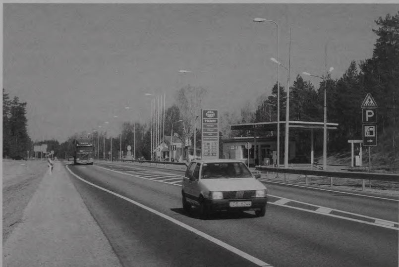
Autoceļa "Via Baltica" Lilastes posma remontam izmantots ISPA finansējums.
