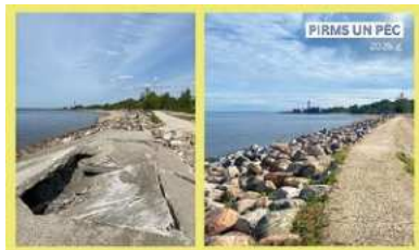
Atjaunots Daugavgrīvas krasta stiprinājuma posms vairāk nekā 500 metru garumā.
